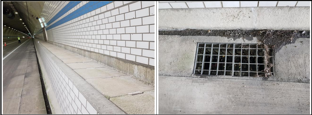
【사진 3.3.23】 공동구 및 배수시설 전경
