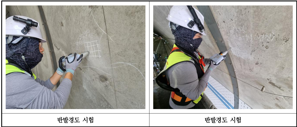
【사진 3.4.2】 반발경도시험 현장사진
