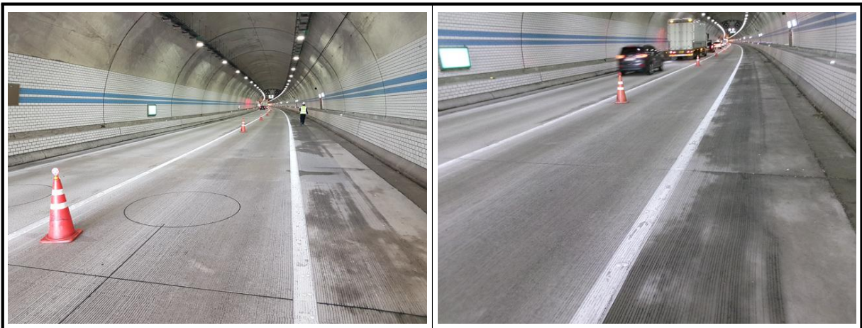
【사진 3.3.11】 포장부 전경
