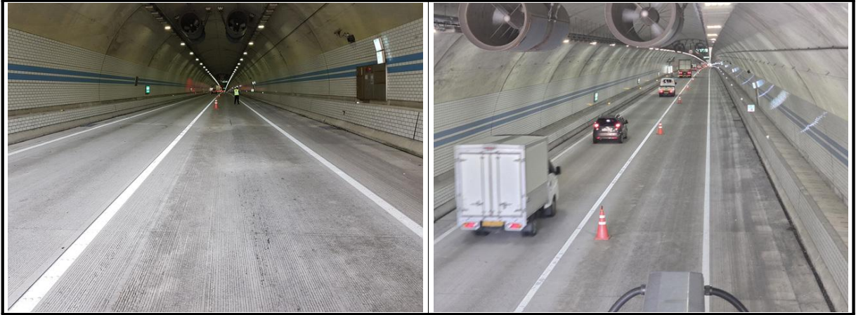
【사진 3.3.25】 포장부 전경
