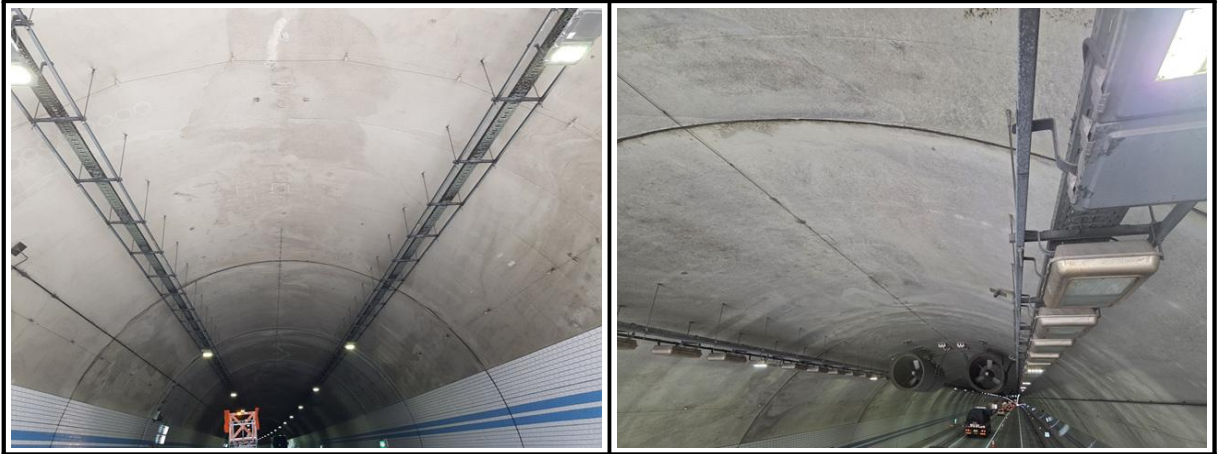
【사진 3.3.15】 라이닝 천단부 전경
