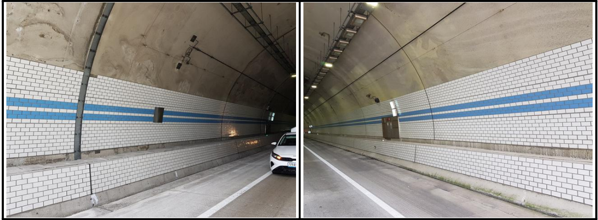
【사진 3.3.17】 라이닝 측벽부 전경
