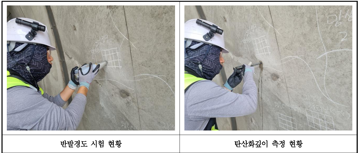
【사진 3.4.1】 콘크리트 내구성조사 현황
