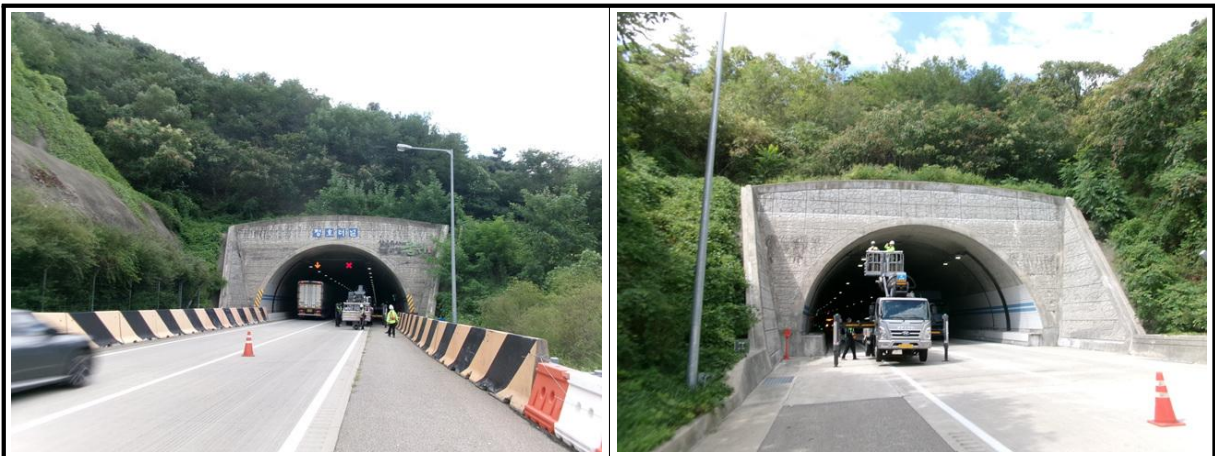
【사진 3.3.19】 갭문 전경
