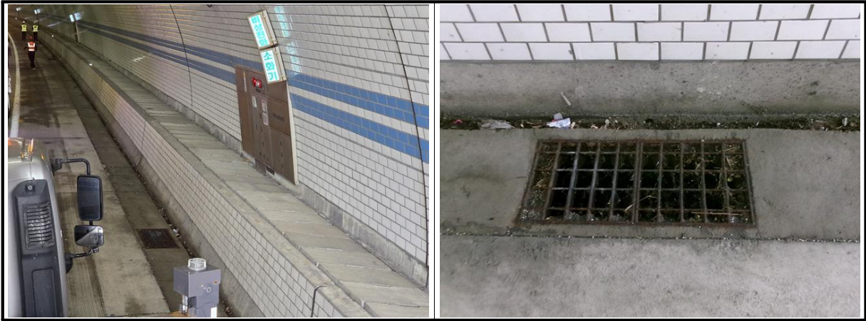
【사진 3.3.9】 공동구 및 배수시설 전경
