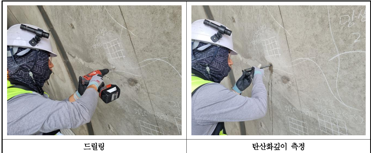
【사진 3.4.3】 탄산화 깊이 측정 현장사진
